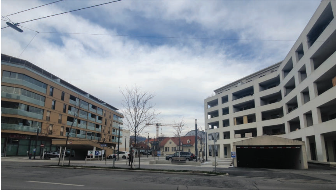
Abbildung 75: Tiefgarageneinhausungen zwischen Prinzessin Veranda und GWS Projekt (eigene Aufnahme)
