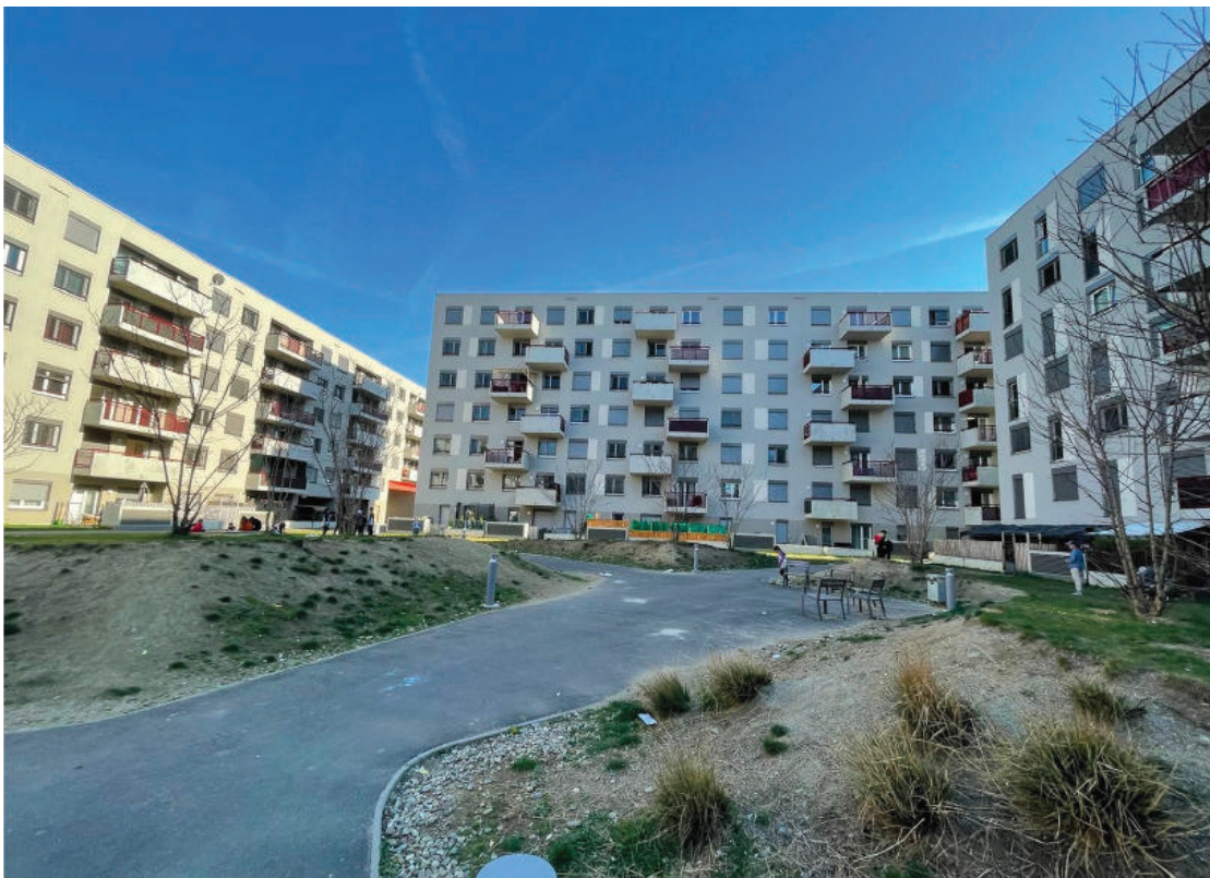
Abbildung 58: Realisierung des Projekts (eigene Aufnahme)
