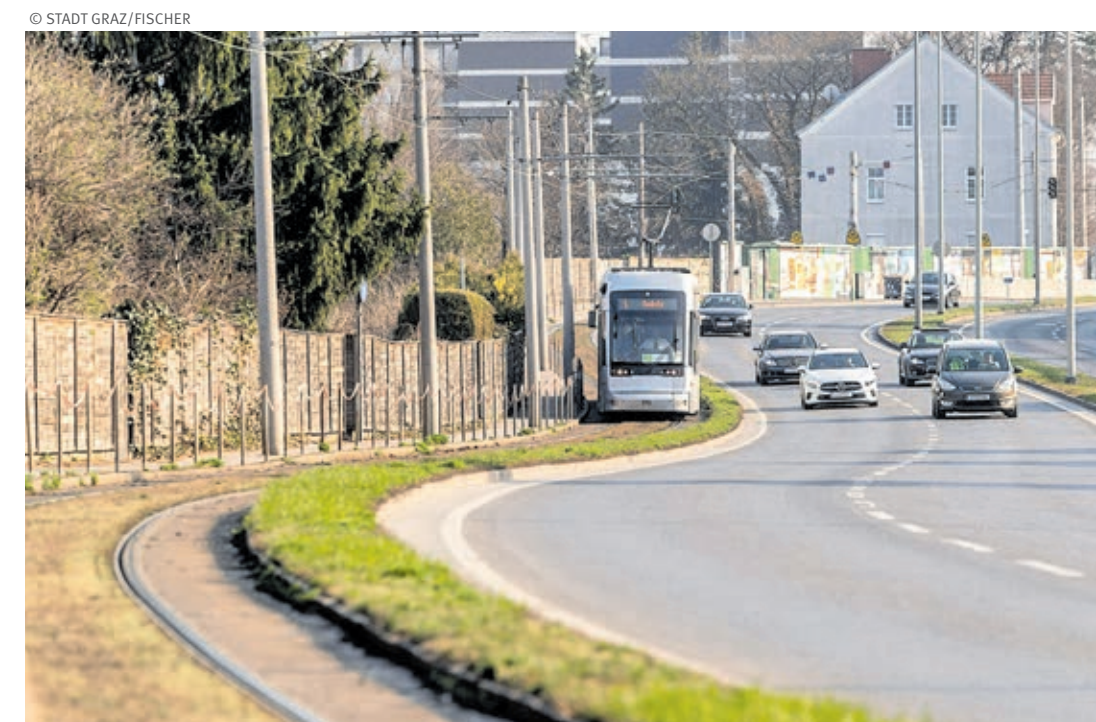
Weichenstellung in Puntigam. Auf einer Länge von knapp 1,4 km entsteht ein zweites Gleis für die Bim.
