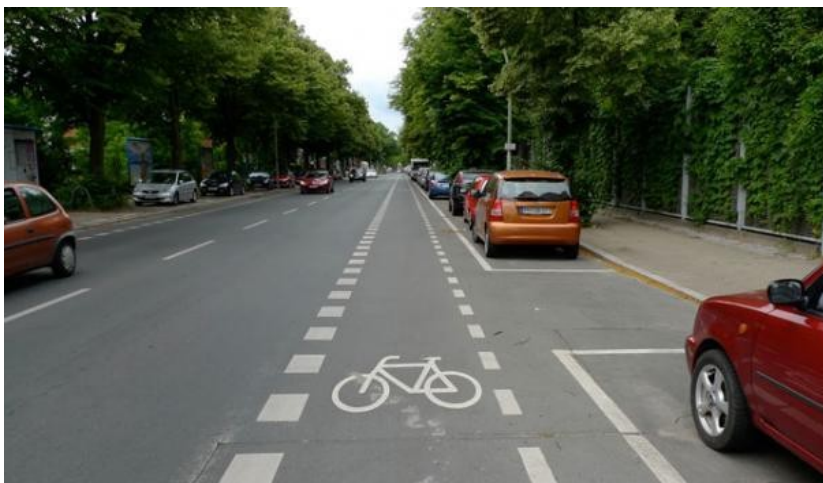
Bodenmarkierung „Sharrow“ (Quelle: Argus Steiermark, https://www.radlobby.at/oesterreich/toedlicheradunfaelle-durch-dooring-gegenmassnahmen-noetig )
